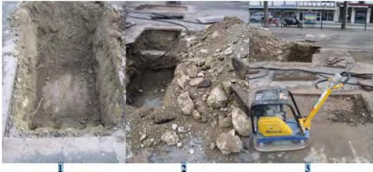
Figure 4 : 1) Première creuse : dalle en béton à -50cm - 2) Deuxième creuse : présence de bordure en granit - 3) Fermeture et remise en place.
