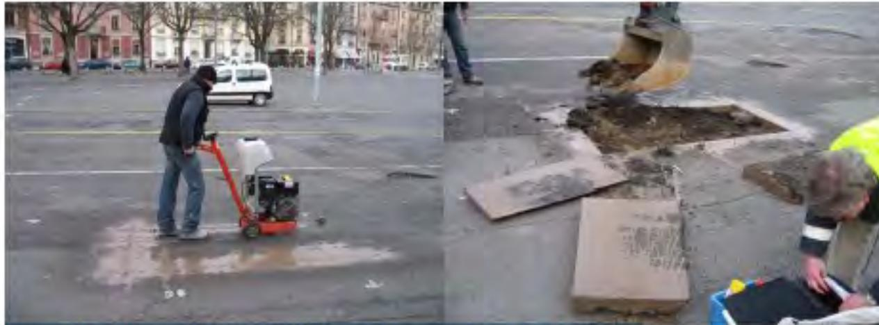
Figure 3 : Découpe de l'enduit bitumineux et creuse du profil n° 1
