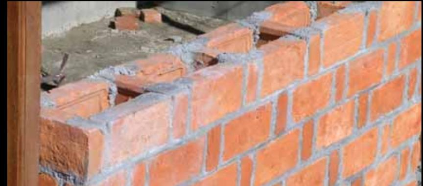
**“Rat-trap bound “ réduction de 30% des briques, économie d’énergie globale de 58% sur la réalisation des murs**
